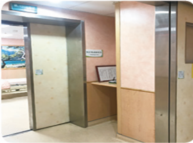
厚鉛隔離防護門板 / 物品傳遞區
